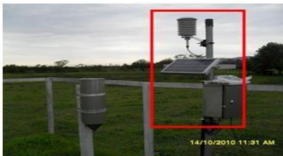
Figura 13 – Estação Fluviométrica Automática Fonte: ANA, 2012..
